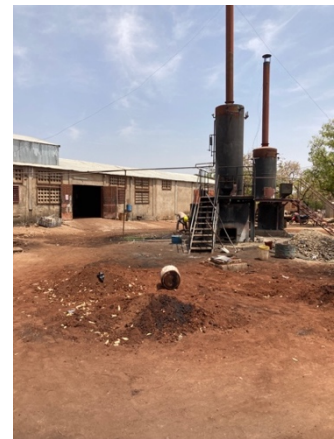
Brennöfen der Fabrik
